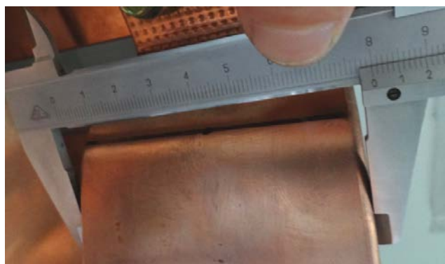
配电母排宽度照片
